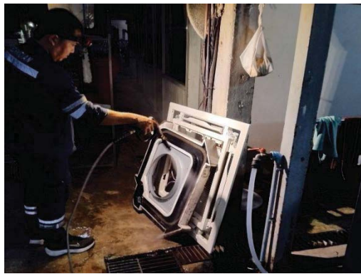
ดูแลตรวจสอบและล้างเครื่องปรับอากาศ
