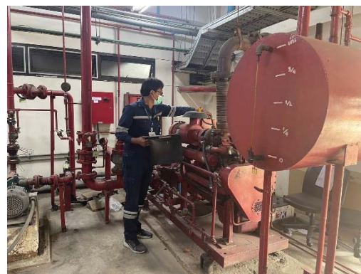
ตรวจสอบระบบน้ำดับเพลิง
