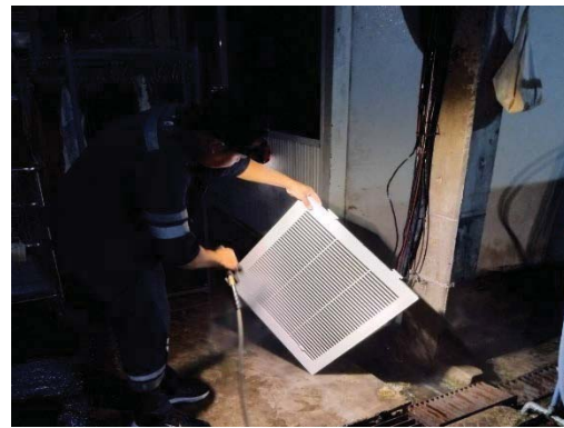
ดูแลตรวจสอบและล้างเครื่องปรับอากาศ
